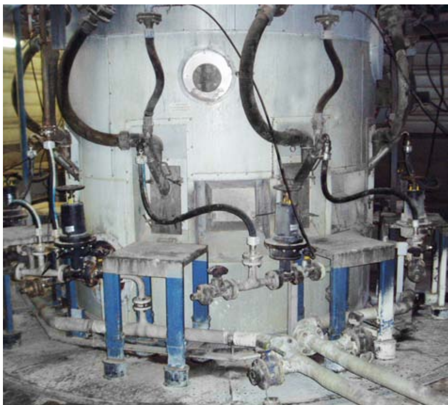
Lances bi-fluides au sein d'un système déjà existant, présentant clairement la nécessité de démonter et de nettoyer les lances fréquemment.
