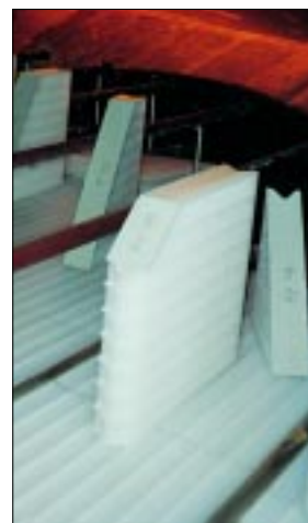
Installation d'un LTV 271
